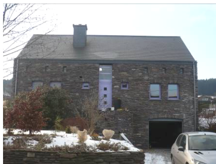
Figure 46 : Maison à Baneux (JNC AWP)
