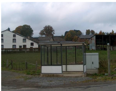
Figure 93 : arrêt de bus et armoire électrique à Hierlot (JNC AWP)
