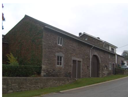
Figure 42 : Maison-bloc à Lierneux (JNC AWP)
