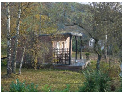
Figure 51 : Chalet en bordure de la Lienne à Trou de Bra (JNC AWP)
