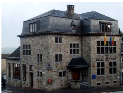
Figure 54 : Maison communale de Lierneux (JNC AWP)
