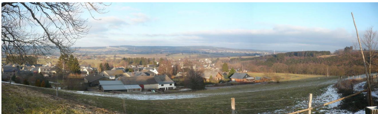
Figure 31 : Vue sur la cuvette de Lierneux depuis la rue des Marcadènes (JNC AWP)
