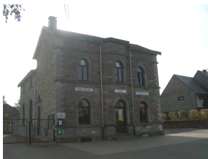
Figure 58 : Ecole communale d'Arbrefontaine (JNC AWP)
