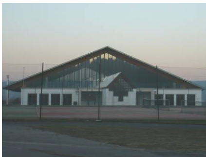
Figure 55 : Hall omnisport de Lierneux (JNC AWP)
