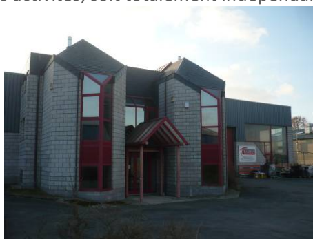
Figure 115 : Bâtiment relais de la SPI + dans le zoning du "Point du Jour" à Lierneux (JNC AWP)
