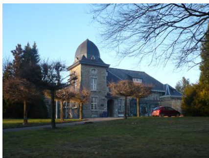
Figure 60 : Pavillon du CHS (JNC AWP)
