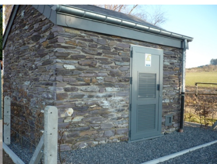
Figure 97 : Cabine électrique à Sart (JNC AWP)
