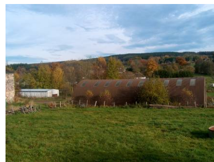
Figure 69 : Hangar agricole à Arbrefontaine (JNC AWP)
