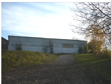
Figure 68 : Hangar agricole à Florêt (JNC AWP)
