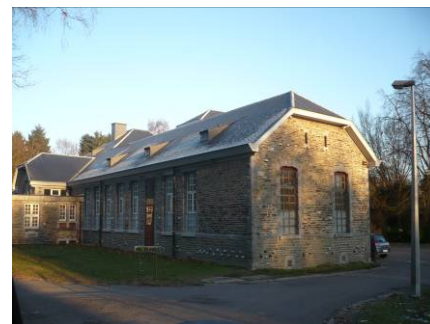
Figure 62 : Pavillon du CHS (JNC AWP)
