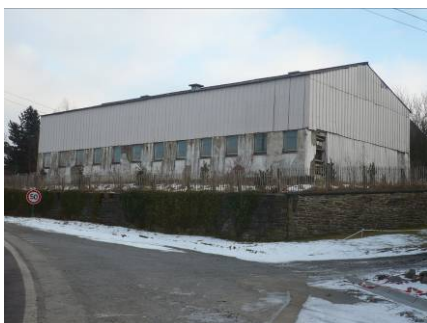
Figure 67 : Hangar agricole à Verleumont (JNC AWP)
