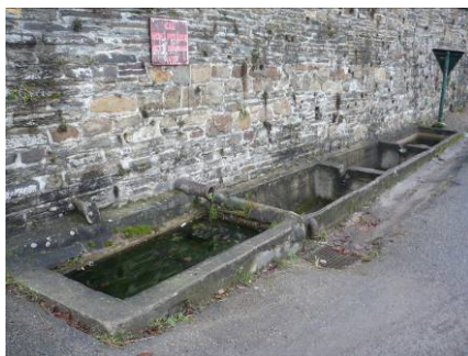
Figure 89 : bac d'eau à Bra (JNC AWP)
