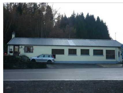
Figure 66 : Garage au Pont de Villettes (JNC AWP)
