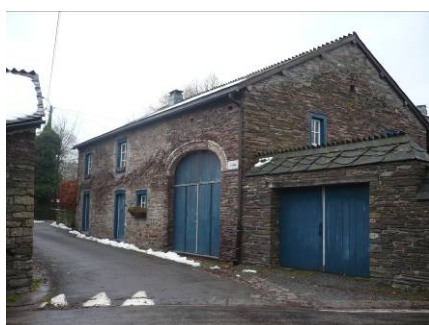
Figure 41 : Maison-bloc à Jevigné (JNC AWP)
