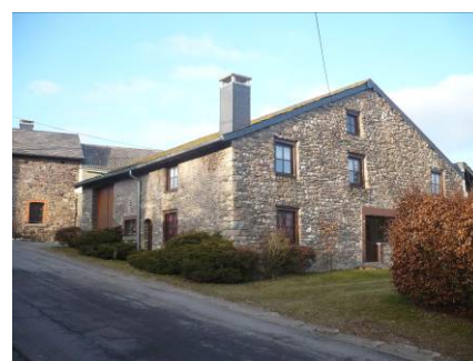
Figure 43 : Maison-bloc à Lansival (JNC AWP)
