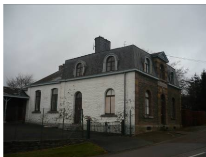
Figure 57 : Ancienne école de Villettes (JNC AWP)
