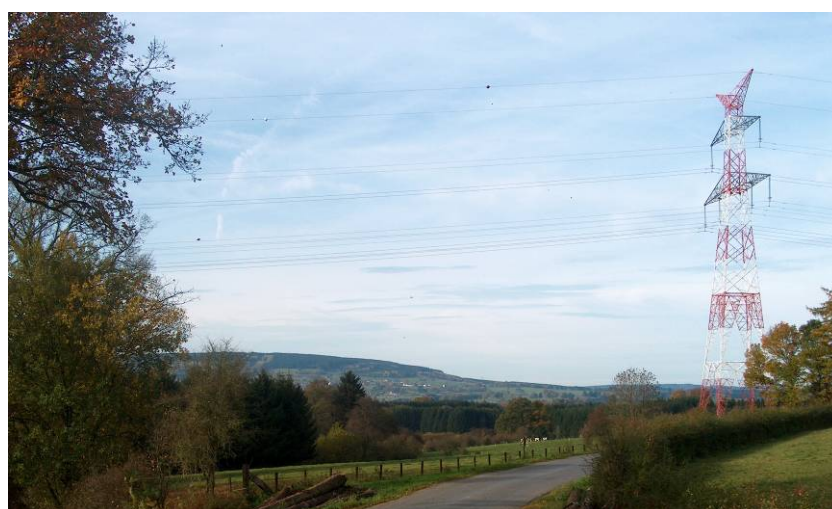
Figure 33 : Ligne à haute tension à Arbrefontaine (JNC AWP)
