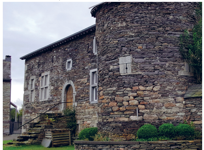
▼ Bâtiments historiques de coeur de village en schiste, JNC AWP
