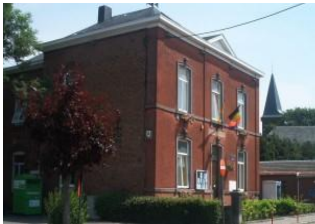
Site rue Duchêne (bâtiment des travaux)
