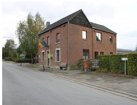
Site rue des Deux Églises
