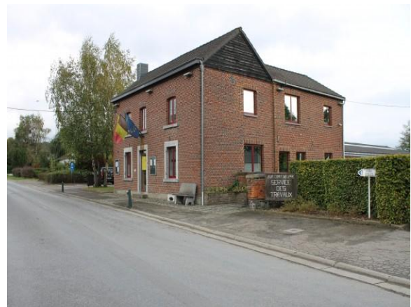
Site rue des Deux Églises
