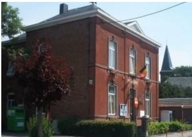
Site rue Duchêne (bâtiment des travaux)
